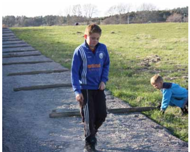
Alla åldrar var igång. Nya stolpar måste upp mellan ridvägen och beteshagen.
