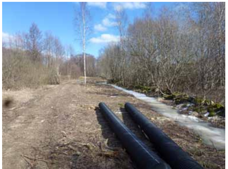
Flera större och mindre rör genomgångar krävdes där ridvägen skulle fram.
