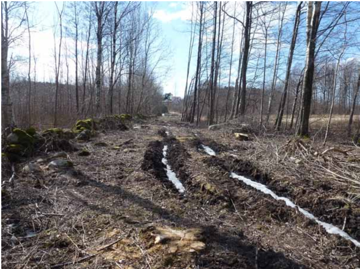
Efter avslutad röjning drog entreprenören igång med sina maskiner.
